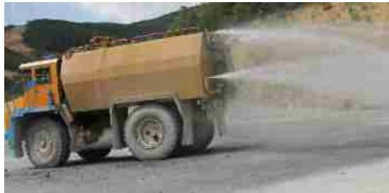
BAGNATURA VIABILITA' DI CANTIERE
